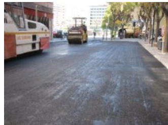
Fotografías 5 y 6: Pulverización y final de compactación del firme.
